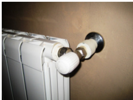
Bild 1: Radiator ohne Thermostatventil
