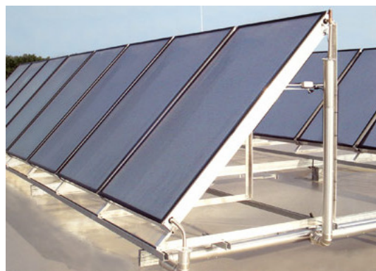
Bild 7: Solarenergie zur Warmwassererwärmung
