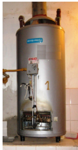
Bild 4: Thermotank zur Warmwasserbereitung
