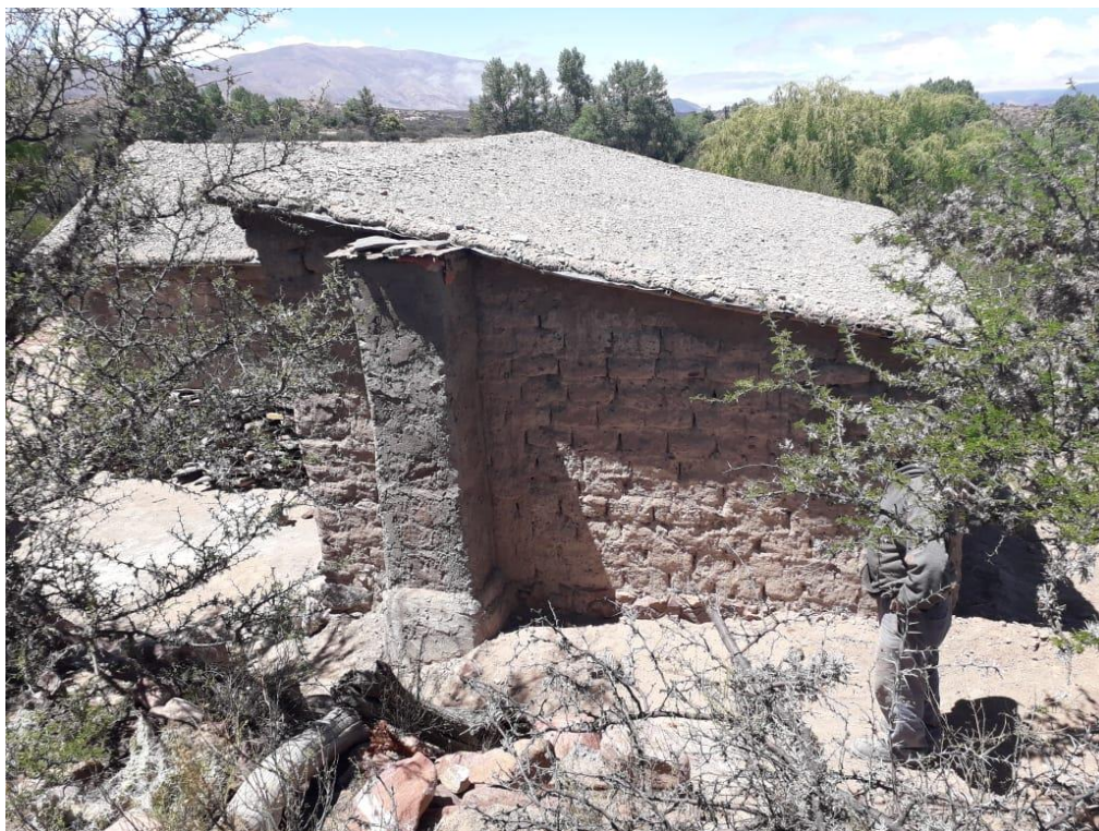
Abb. 1: Blick auf den Schornstein für die Solarheizung, der dem Transport von warmer Luft dient.
